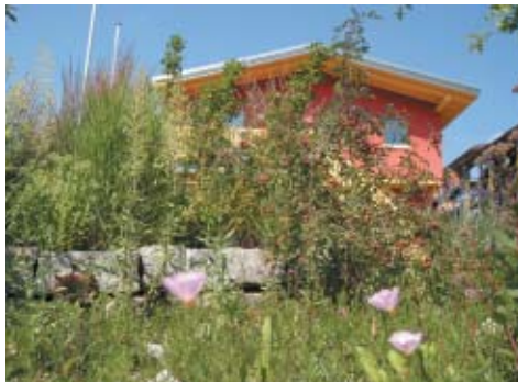
Rund um die Trockenmauer wachsen und gedeihen heimische Pflanzen und Gräser. Im Hintergrund das Firmengebäude von Gerold Weber Solartechnik.
