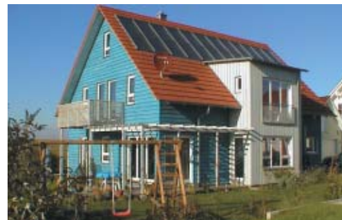
In der „Casa Azul“, dem „blauen Haus“ der Familie Müller, sorgen 36 m 2 Sonnenkollektoren für eine wohlige Wärme. Für die restlichen 40% Energiebedarf für die Heizung und warmes Wasser sorgt ein Stückholzvergaserkessel.
