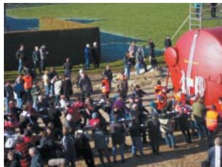
Über 100 Freiwillige halfen, den 15 Tonnen schweren Speicher von der Produktionshalle der Jenni Energietechnik AG zum Bauplatz des ersten rein solar beheizten Mehrfamilienhauses zu ziehen.
