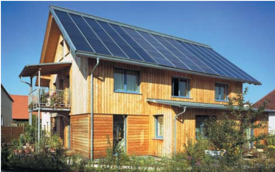
„Wenn alle anderen schon heizen, geht es bei uns noch solar“, freuen sich Gisela und Volker Diergardt. Im Winter 2004/2005 mussten sie nur 20 Mal zuheizen.
