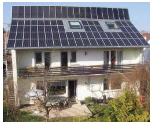
Das Haus von 1962 nach der solaren Altbausanierung
