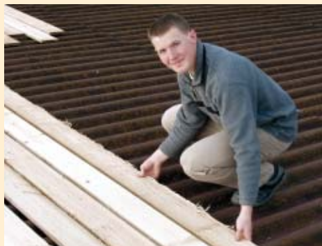
David Hilbert beim „Vorverrauben“ der Holzschalung für die Fassade des Sonnen-Zentrums, das derzeit in Rottenburg-Oberndorf entsteht
