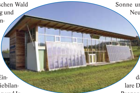
110 m 2 Kollektoren sorgen für 100 Prozent sonnige Wärme. Im Februar feierte das Naturparkhaus sein dreijähriges Bestehen.
